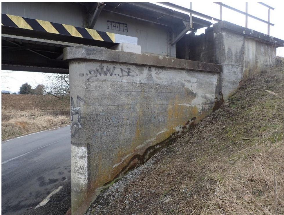
Foto 3: Degradovaný beton s výluhy
