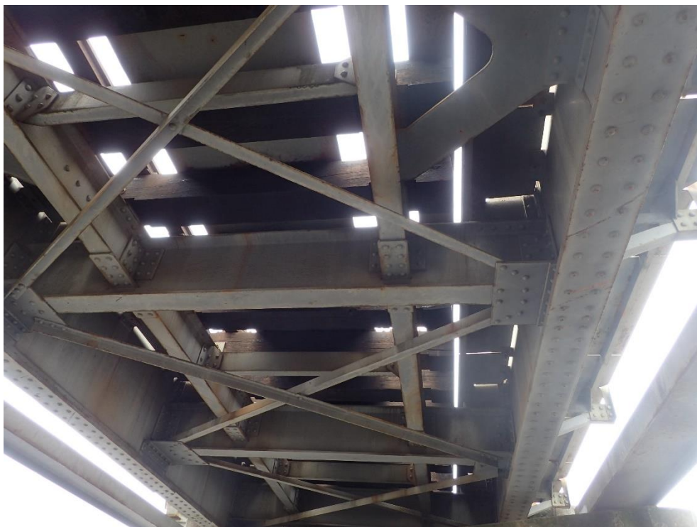
Foto 5: Koroze ocelových prvků nosné konstrukce
