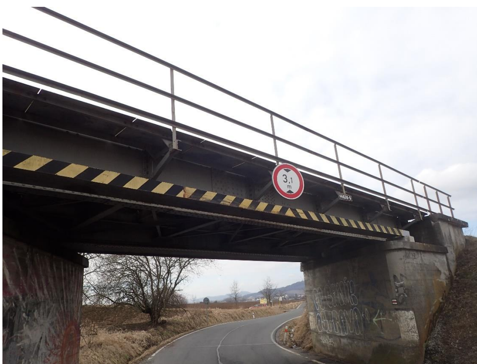
Foto 4: Pásnice hlavního nosníku lokálně zdeformované železniční dopravou
